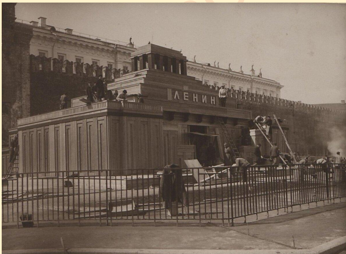
Работы по возведению 2-го деревянного мавзолея.
